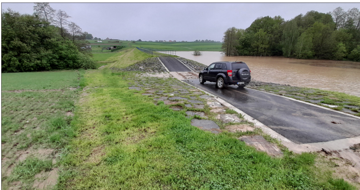
MVN Markvartovice F – nouzový přeliv s max. dosaženou hladinou při povodni 14.5.2021.
