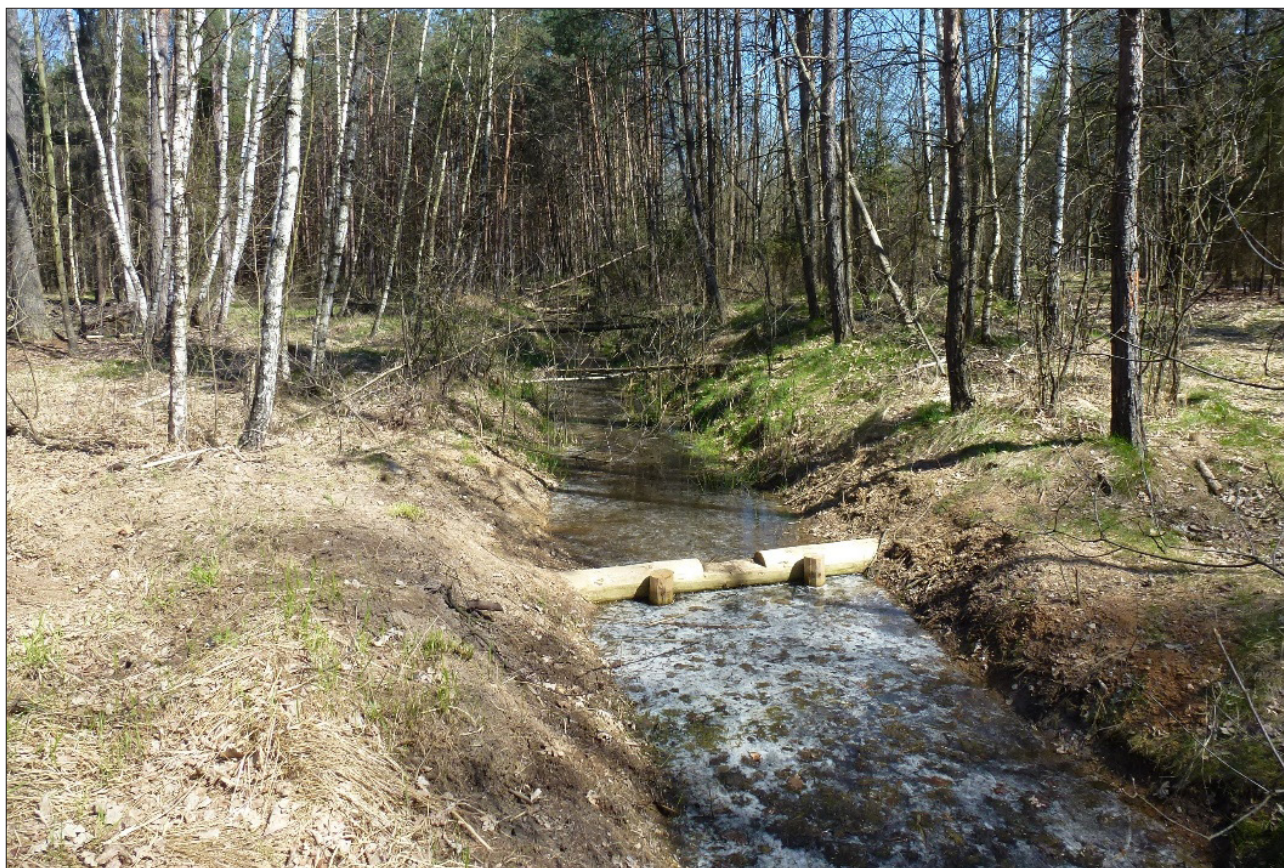
Obr. 5: Hrazení LTM v povodí Smržovského potoka (1. etapa) – Nový Ples, zahrazení odvodňovací sítě kanálů v délce 2,8 km vybudováním 2 stavítek a 14 dřevěných hradičích stěn ovlivňujících 16 ha lesa, vyhloubení 1 periodické tůně, náklady 196 tis. Kč.
