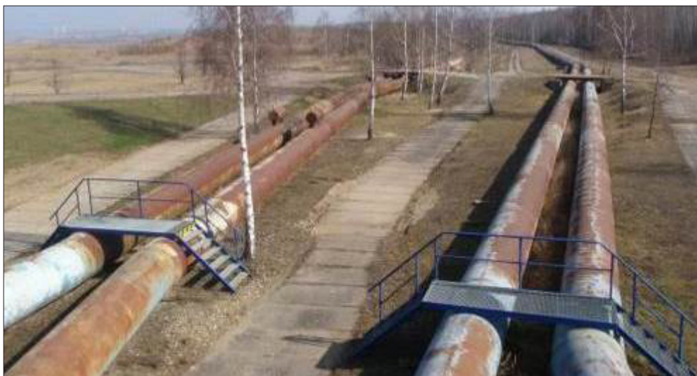
Obr. 2: Pohled na trubní přeložku Bíliny, stav v roce 2016.
