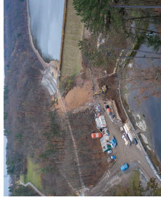
VD Hostivař - zkapacitnění bezpečnostního přelivu
