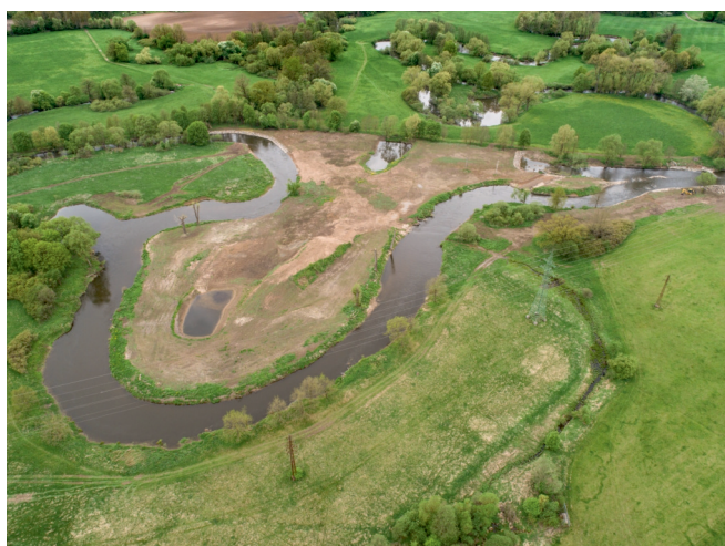
Orlice, Týniště nad Orlicí, revitalizace ramene Jordán - znovuzprůtočnění rameno v květnu 2021
