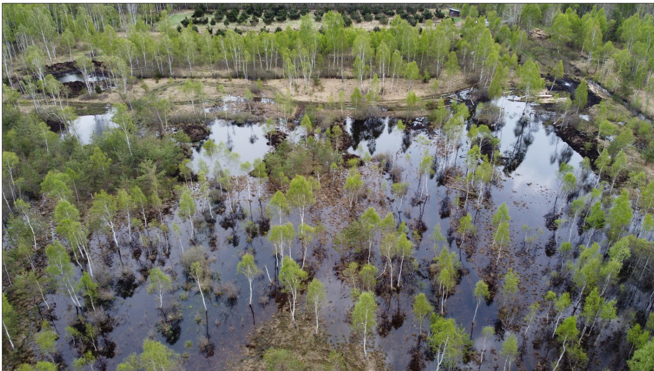
Obr. 15: V průběhu realizace revitalizace Borkovických blat došlo během srážkové epizody v květnu 2021 k zaplavení cca 30 hektarů staveniště.
