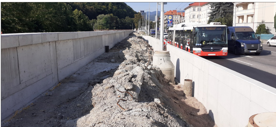
Realizácia nábrežného múru v blízkosti cesty I/66.
