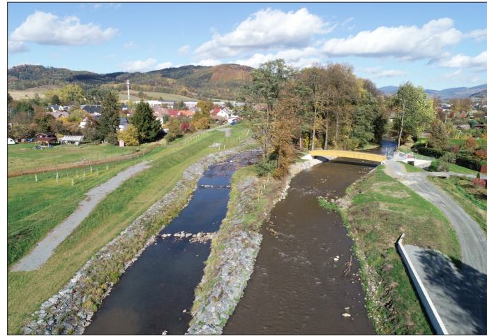
Nové koryto povodňového parku.
