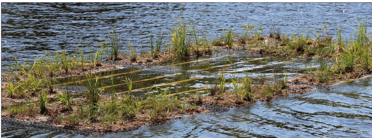
Obr. 2: Ostrov gabionové konstrukce, vpravo nahoře detail ochranného prvku proti poškození. Uprostřed detail na kořenové systému rostlin a ostrov zamrzlý v ledu. Dole ostrov po jedné sezóně, uprostřed je laguna pro ponořené rostliny.
