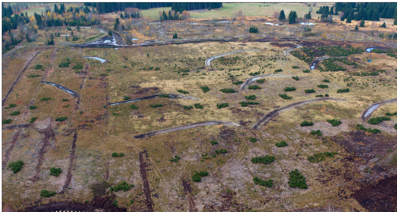
Obr. 3: Revitalizace Perninského rašeliniště – Krušné hory, obnova vodního režimu vytěženého rašeliniště o rozloze 66 ha, 390 přehrázek, 2 vzdouvací objekty, 8 tůní, vegetační úpravy, náklady 7,7 mil. Kč.
