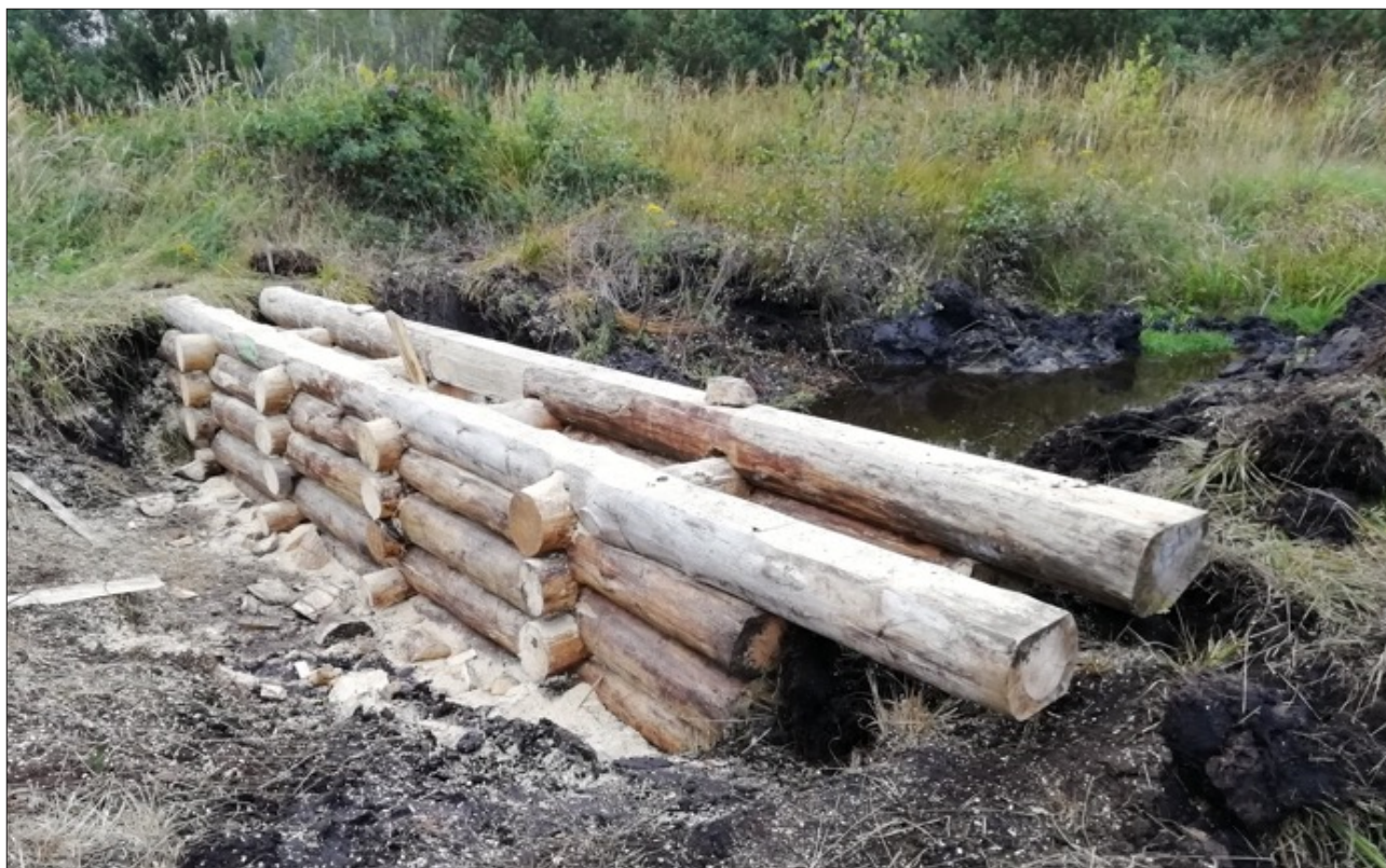
Obr. 12: Realizace dvojitého srubového hradícího objektu na hlavním kanále Borkovických blat.
