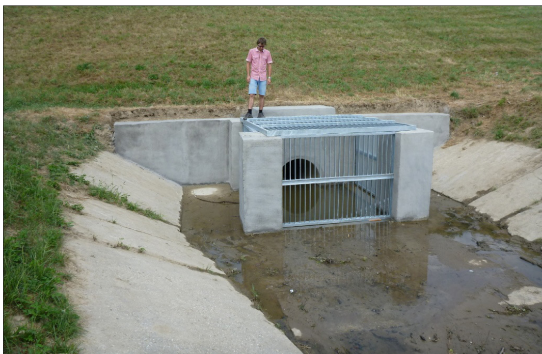
MVN Bartošovice III – vtokový objekt po rekonstrukci v roce 2013.
