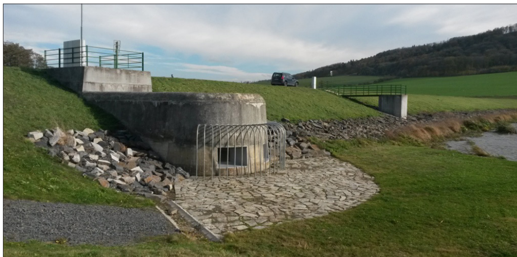
MVN Starý Jičín – po úpravě bezp. přelivu a snížení provozní hladiny 30.10.2018.
