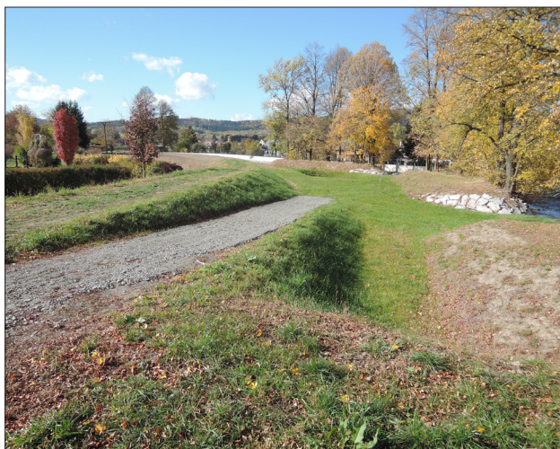
Odsazená hráz a ochrana stávajících břehových porostů.
