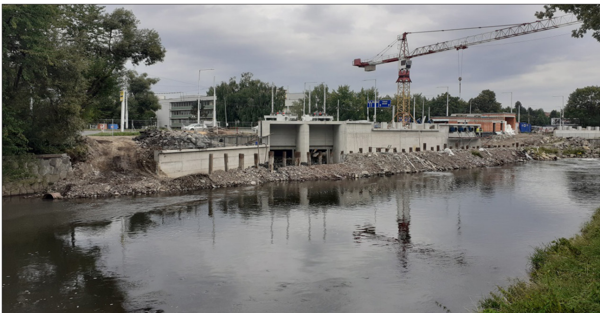
Pohľad na zátvorný objekt počas realizácie.
