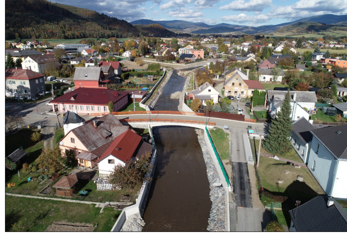
Dokončování prací na soutoku Losinky a Desné nad novým mostem.
