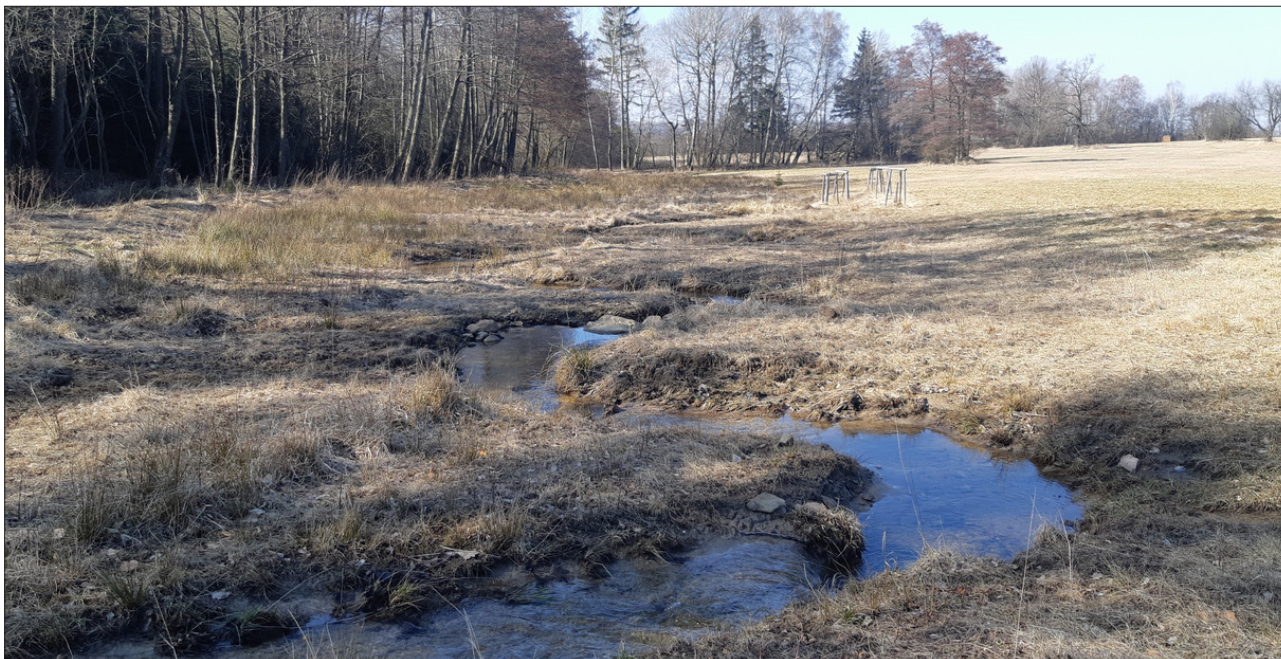
Revitalizace úseku Debrného toku u Nasavrk. Stavba, dotovaná v rámci operačního programu Životní prostředí, byla investorem, Lesy ČR, s.p., dokončena v roce 2020. Ukázka zjevně dobře provedené revitalizace drobného vodního toku – výrazně zvlněné, dnovými pasy z kameniva stabilizované a členěné koryto je přirozeně málo kapacitní a málo zaklesnuté proti okolnímu terénu. Příležitosti napomoci přirozeně akumulaci a retenci vody v území a potok ekologicky rehabilitovat bylo zřejmě dobře využito. (Foto P. Královcová, 2022)
