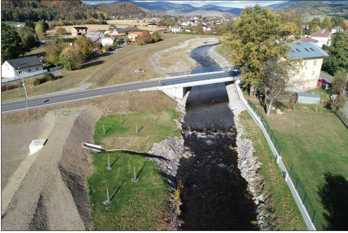
Dokončená PPO u mostu ŘSD s rozvolněním koryta.
