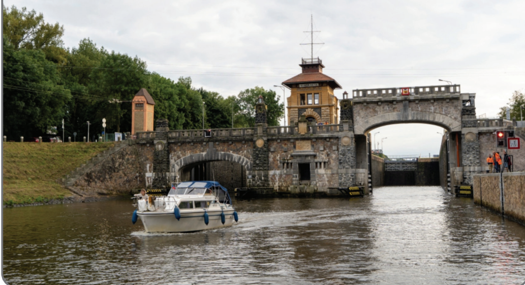
Stav po úpravách - zdvižený most na dolním ohlavi
