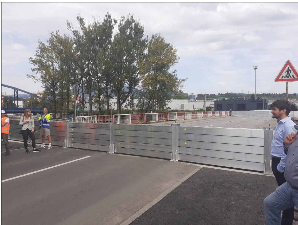
Skúška mobilného hradenie na moste pri Smrečine počas dopravnej uzávierky.
