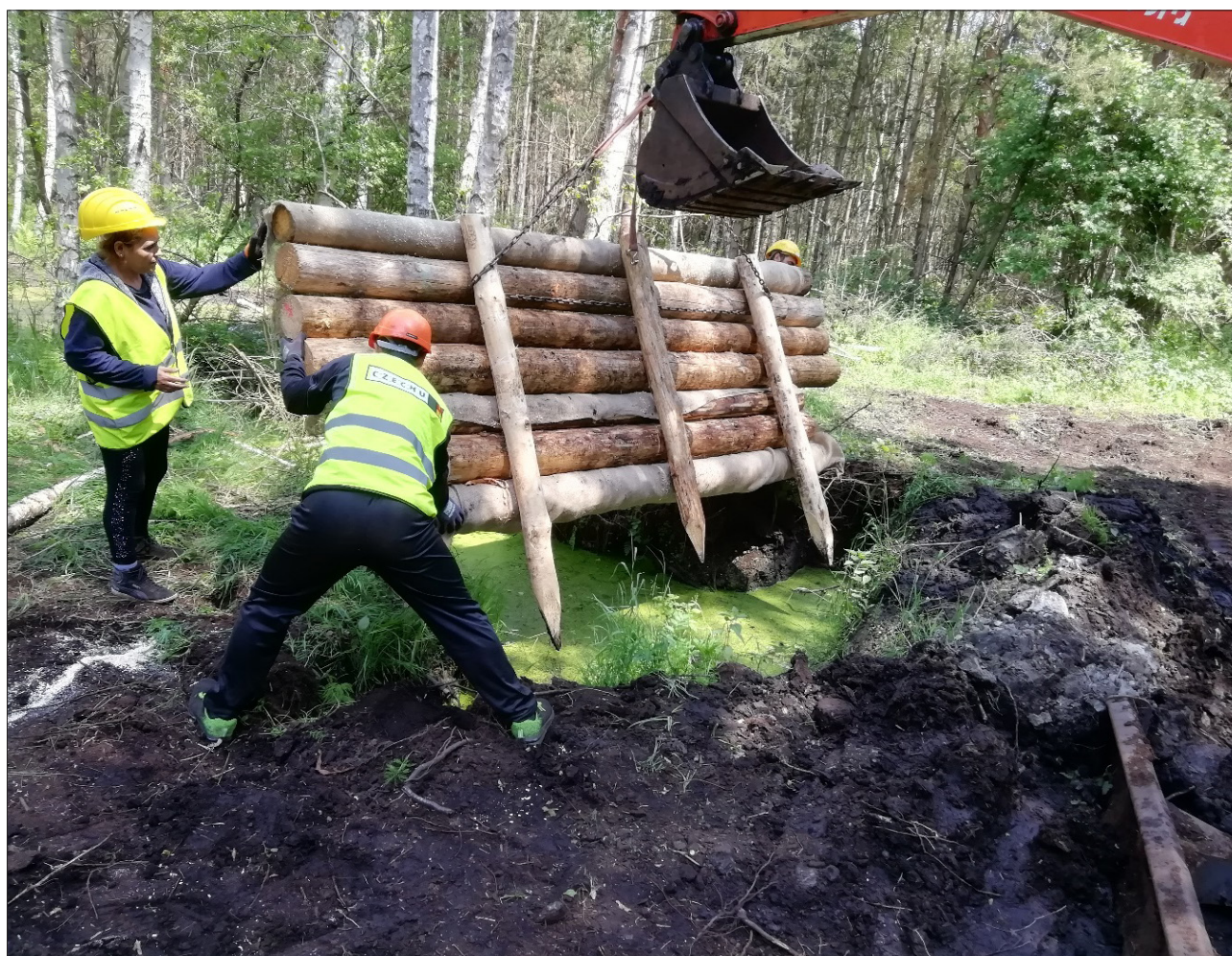
Obr. 11: Instalace hradíkového objektu na Borkovických blatech. Vzhledem k zavodnění kanálů se osvědčilo mechanizované ukládání kompletních hradíkových stěn.
