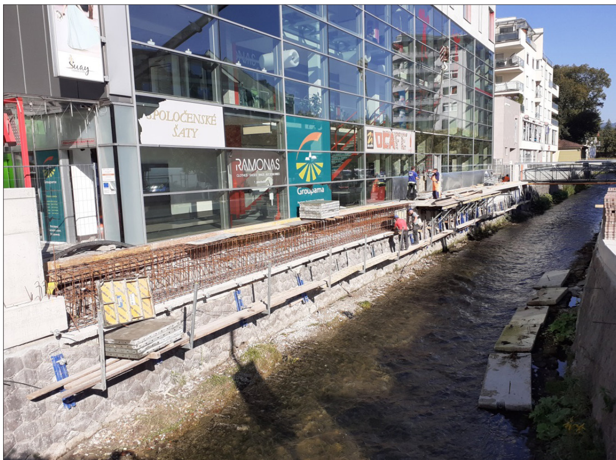
Realizácie prác v stiesnených pomeroch na úseku č. 4.
